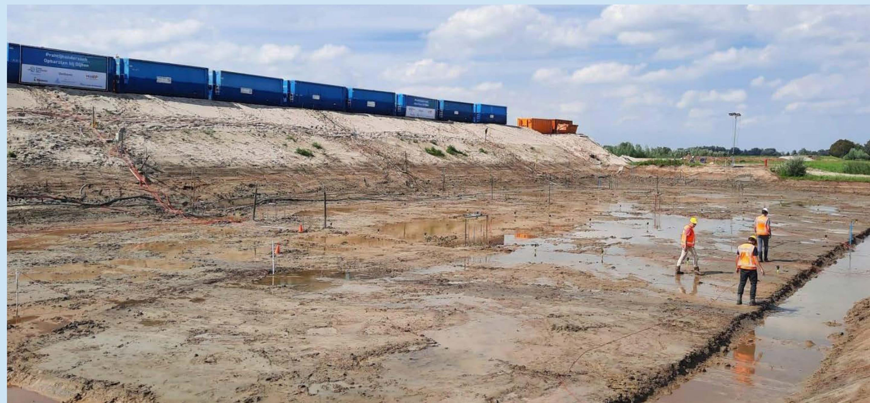
Dijk bij het Reevediep speciaal gebouwd voor de grootschalige praktijkproeven
