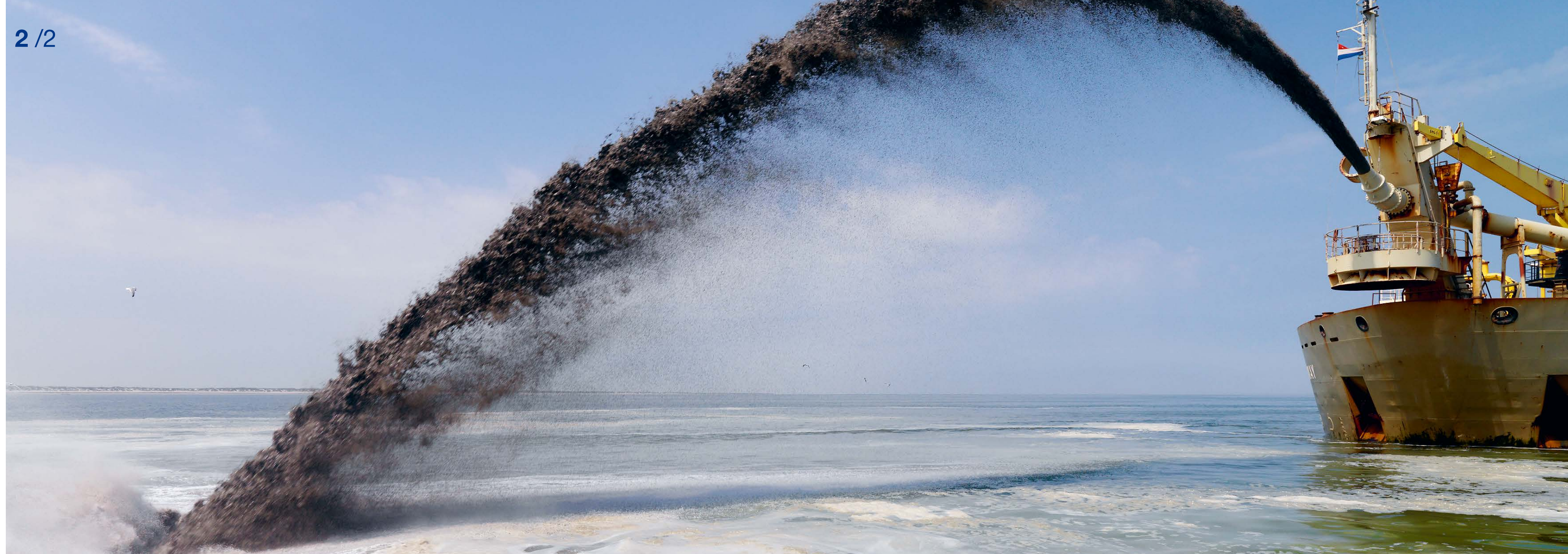
Rainbowen is één manier om het zand voor of op de kust aan te brengen.
