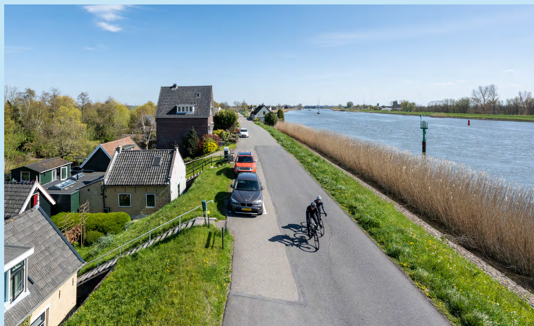
Dijk langs de Hollandsche IJssel. Het water ligt een stuk hoger dan het achter de dijk gelegen land. De huizen van het dorp liggen eigenlijk onder het waterpeil.
