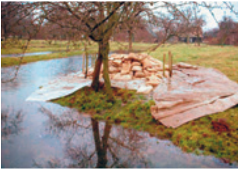
Figuur 4.1 Opgekiste zandmeevoerende wel
