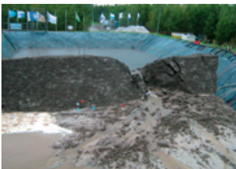
Figuur A.6 Doorbraak na verzakking van een proefdijk als gevolg van piping (IJkdijk proefopstelling, september 2009, IJkdijk locatie Bellingwolde, Groningen)
