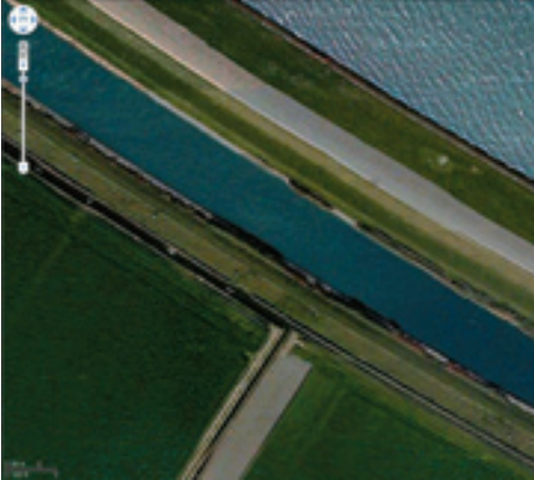
Figuur C.3 Dijkkring 25, Zuiderdiepdijk (hm 6,10 – 7,40) – Haringvliet
